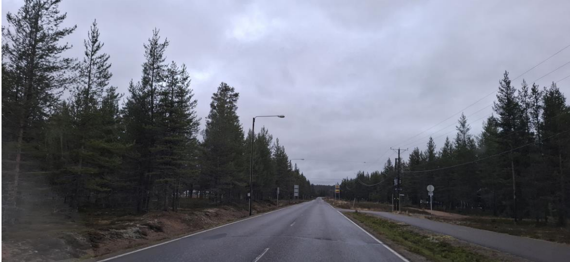
8. Maantie suunnittelualueen kohdalta kohti pohjoista. © J. Lokio 10/2025
